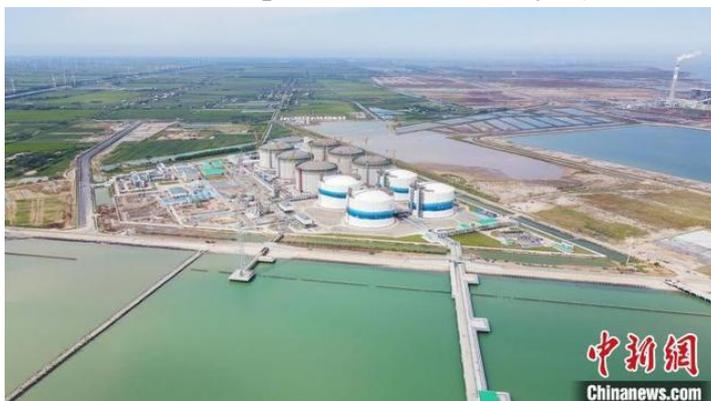
основной конструкции крупнейшего в Китае СПГ-хранилища (агентство Chinanews.com, 22 сентября). Оно состоит из шести резервуаров емкостью 270 тыс. кубометров и еще четырех по 220 тыс кубометров, общая вместимость 2,5 млн кубометров. Крышка каждого из резервуаров сопоставима с площадью футбольного поля и весит почти 1200 тонн.
